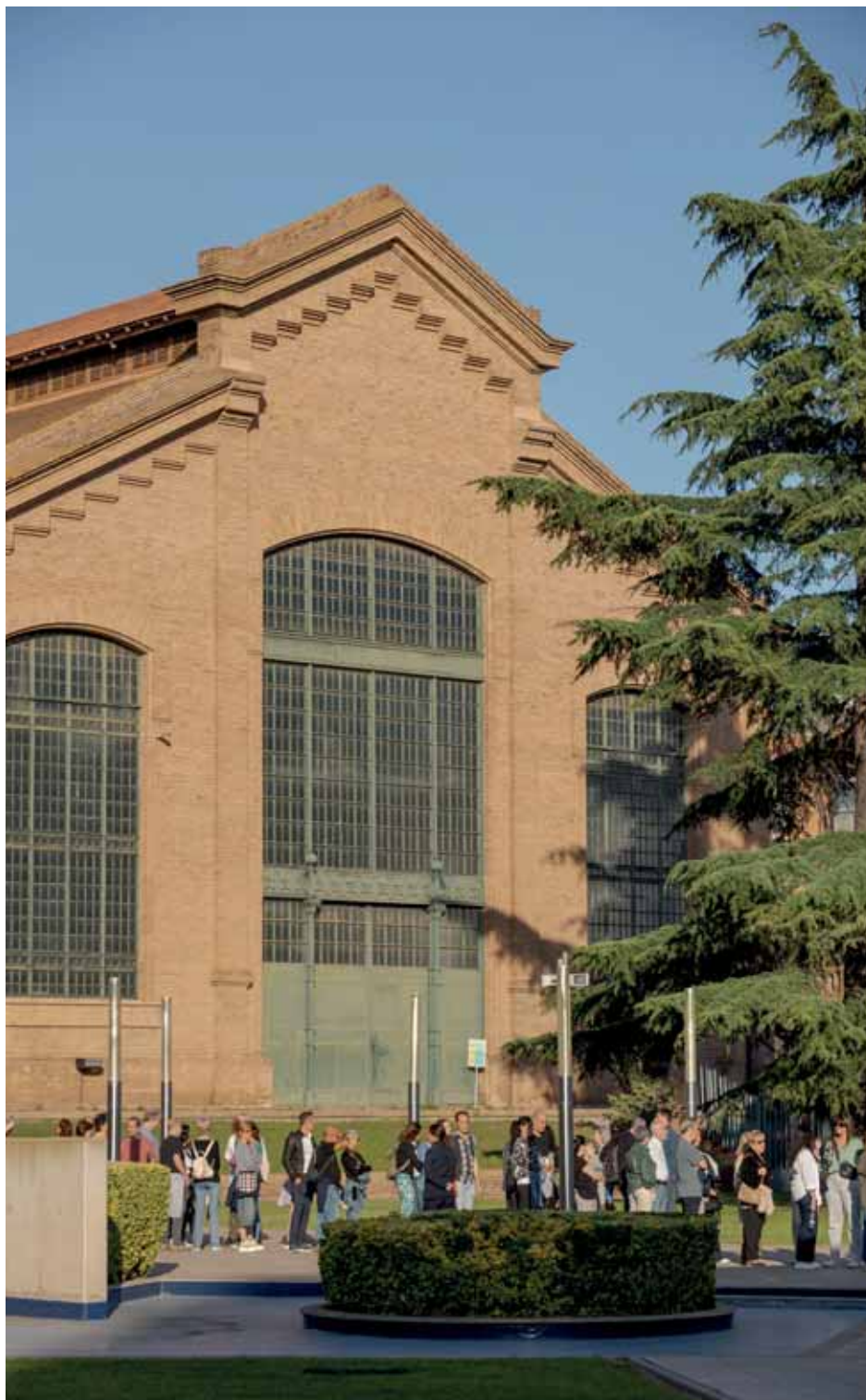
La planta d'extracció i bombament d'aigua ha estat en funcionament des del 1909 i va ser projectada per l'arquitecte modernista Josep Amargós i Samaranch
